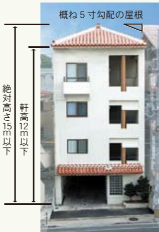
建物の高さは、軒高さが12m以下で、絶対高さは15m以下です。赤瓦の勾配屋根にすることで、歴史的風景に調和を図ります。
